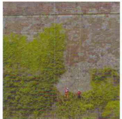
Due momenti della ripulitura della parete della fortezza savonese
