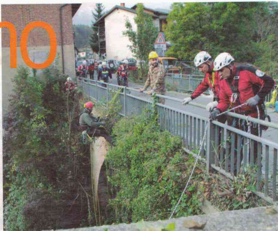
Una squadra alpinistica in calata da un ponte, per eliminare arbusti e infestanti.
